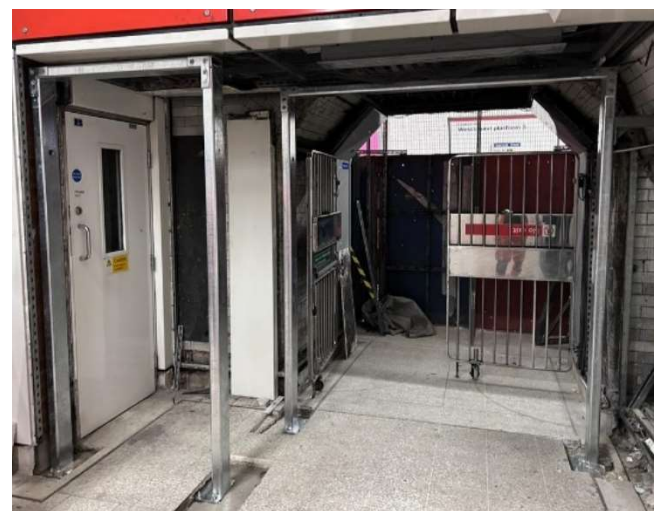
Mild Steel Fire Door Frames
